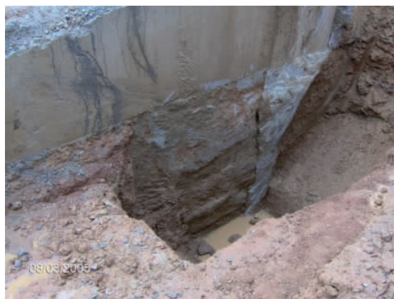
图4 开挖检查表面及接头
