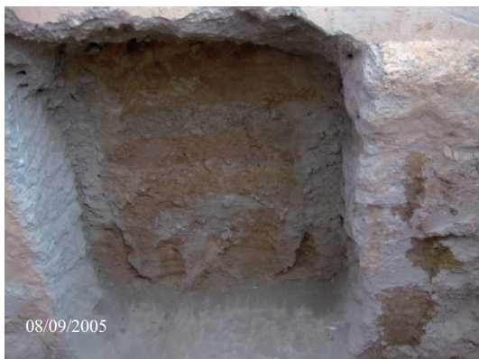
图3 墙体检查取样
