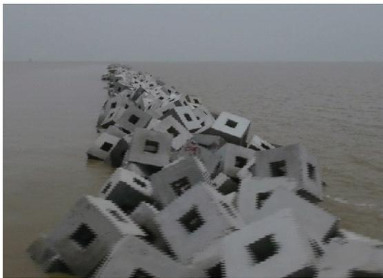
图8 吊装完成后的典型断面
