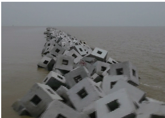
图8 吊装完成后的典型断面
