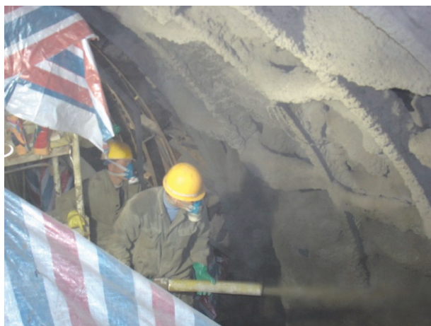
图3 人工应急喷射混凝土支护
