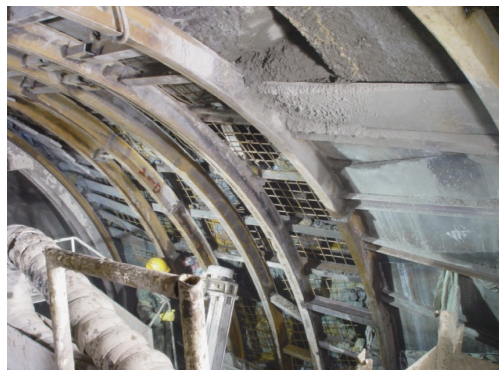
图 2 钢瓦片与钢拱架钢筋网联合支护
