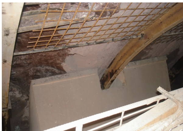
图 1 TBM 撑靴部位围岩加固处理
