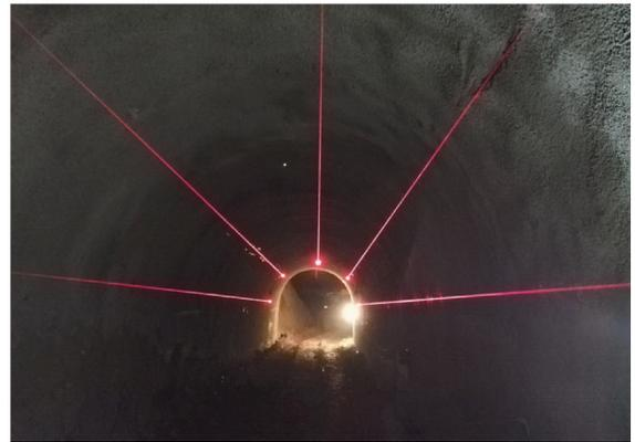
图4 激光导向仪安装位置及应用效果
