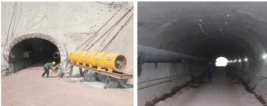
图 3 通风设备及电缆安装
