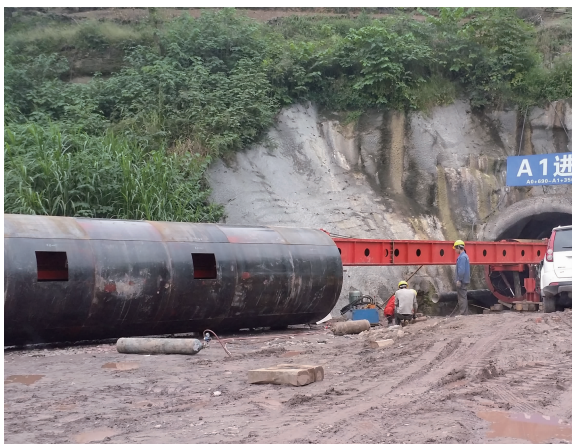
图2 针梁式钢模台车组装
