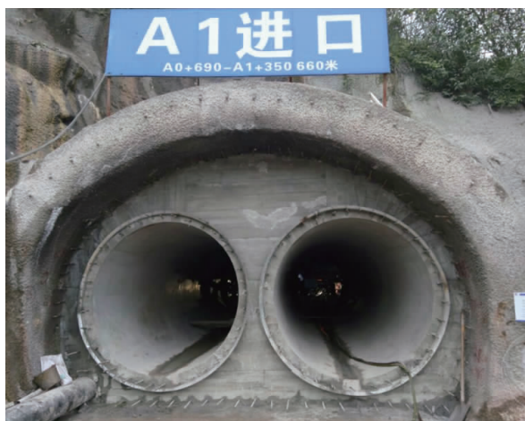
图6 台车浇筑效果
