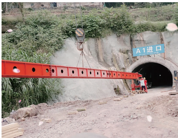
图2 针梁式钢模台车组装
