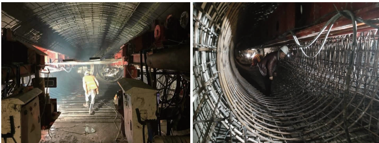
图3 钢筋安装
