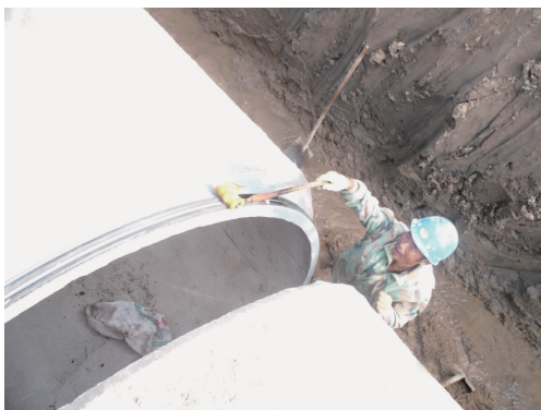
图3 橡胶圈润滑处理
