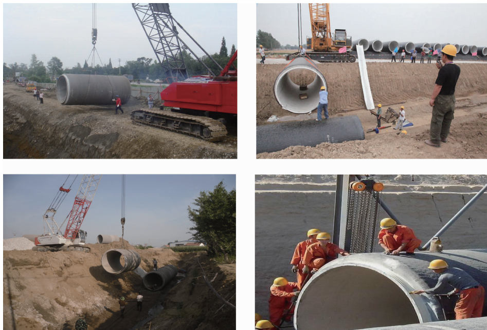
图 2 管道铺设安装
