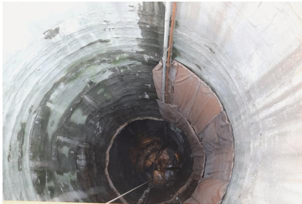
图 12 竖井滑模衬砌混凝土施工照片
