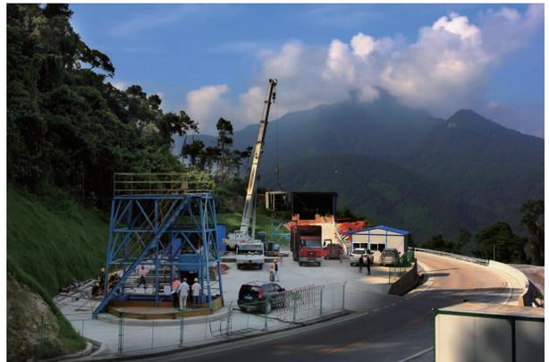
图7 竖井全断面开挖支护井口提升系统布置照片
