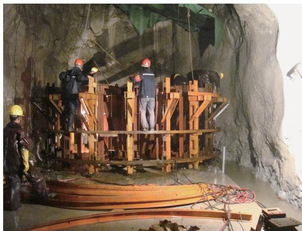
图10 竖井滑模安装施工照片
