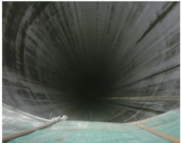
图 13 竖井滑模混凝土浇筑完成施工照片
