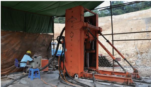
图2 反井钻机导孔施工照片
