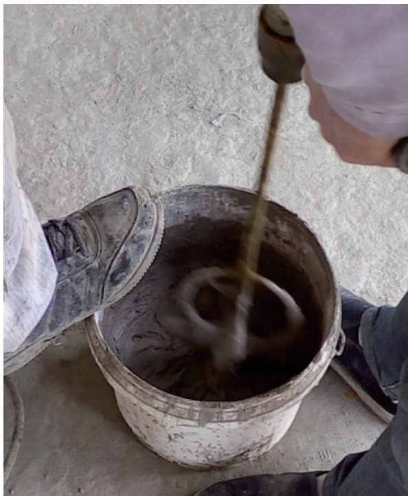
焊接钢制圆环方法搅拌图
