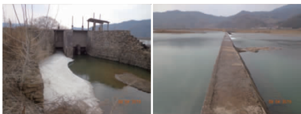
图1 红旗一坝拦河坝现状
