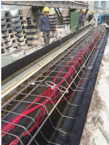
图 2 土压力盒安装就位
