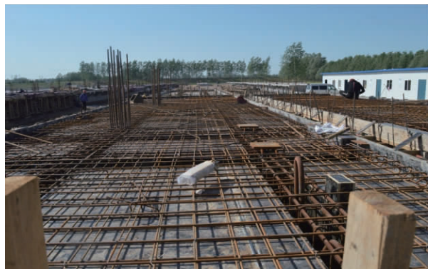
(b) 技术人员对浇筑前的大梁进行质量检查
