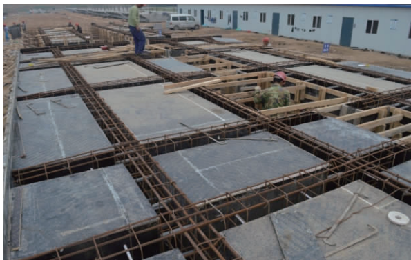
(a) 主梁钢筋绑扎完成后板底面模板加固
