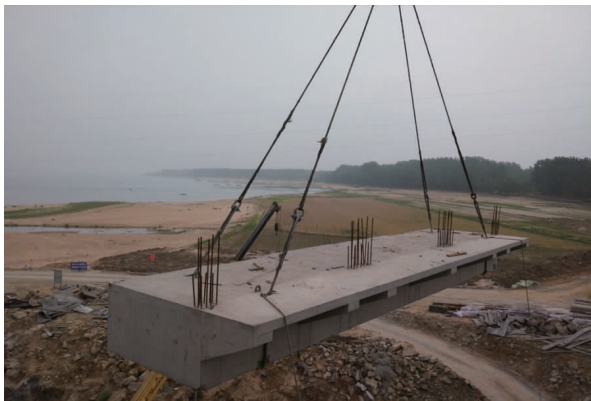
图 6 吊装时使用预留的专用吊装孔
