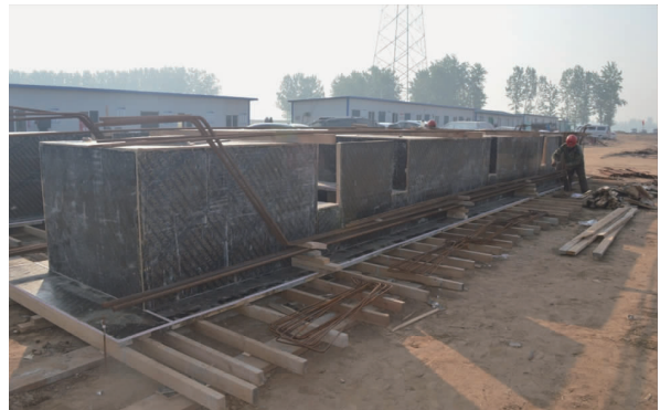
图3 内模支立完成后绑扎主梁钢筋
