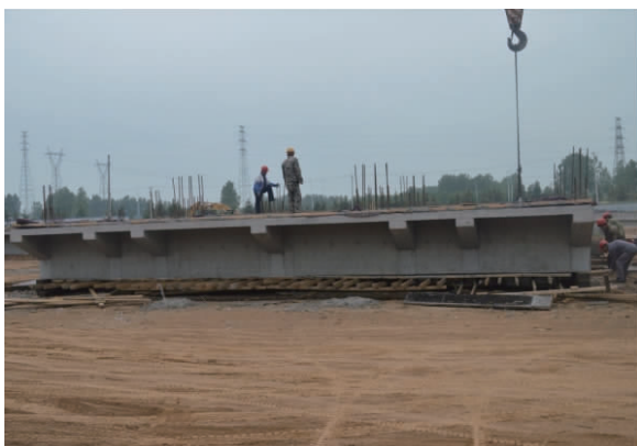
(a) 大梁支撑后拆除底模和内模
