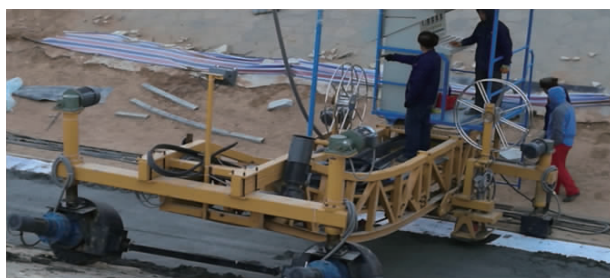
图 3 嵌入式置缝机施工作业现场图片
