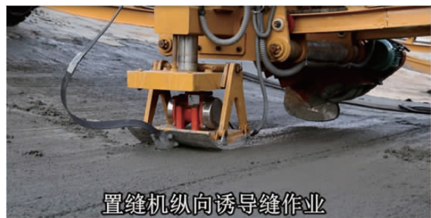
图6 纵向诱导缝作业
