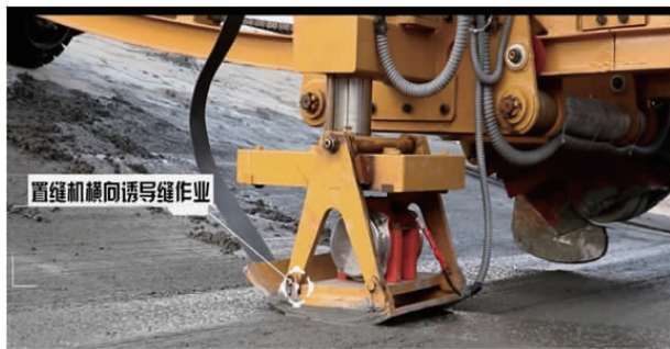
图4 横向诱导缝作业
