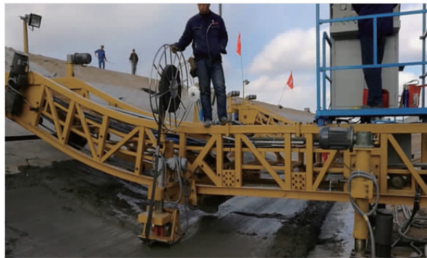
图5 纵向伸缩缝作业
