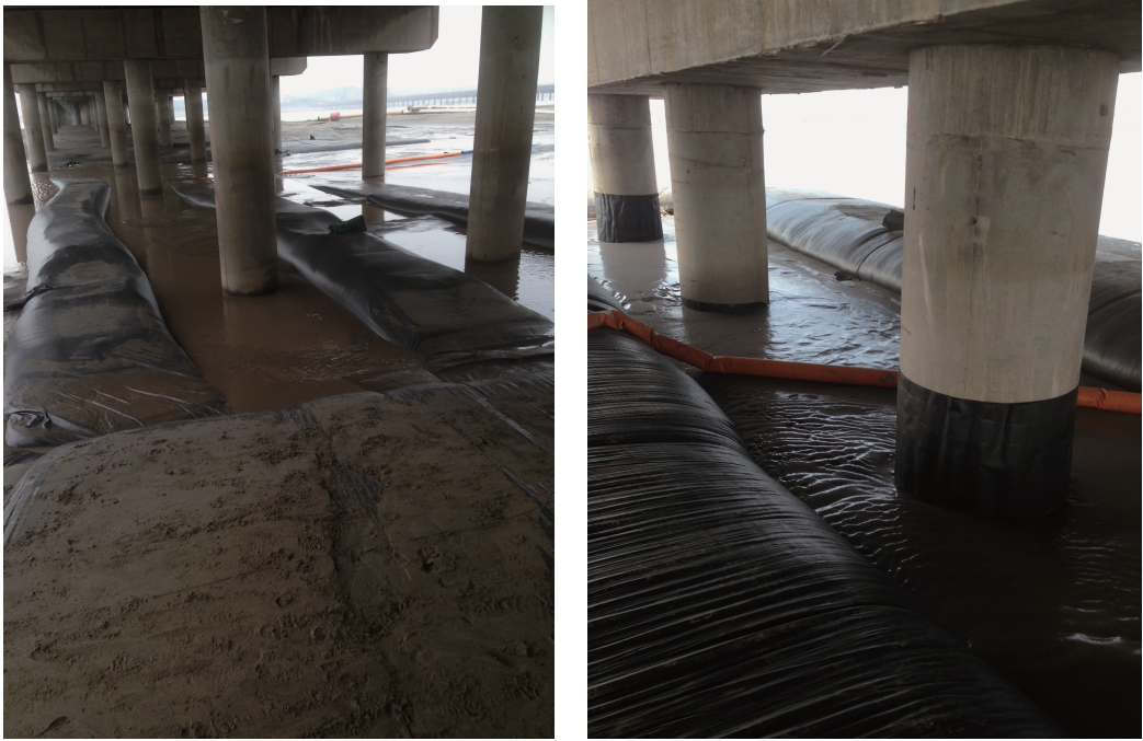
图 2 桥桩间砂被现场施工
