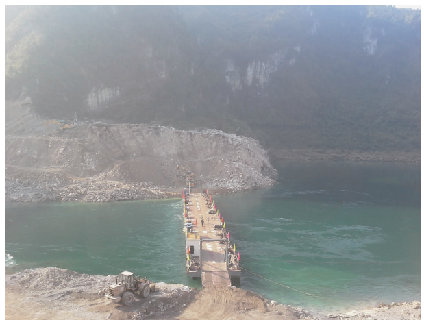
图 2 浮船正常运行
