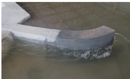
图3 方案二溢洪道进口水流流态
