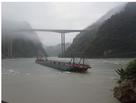
图3 浮船洪水期间锚固
