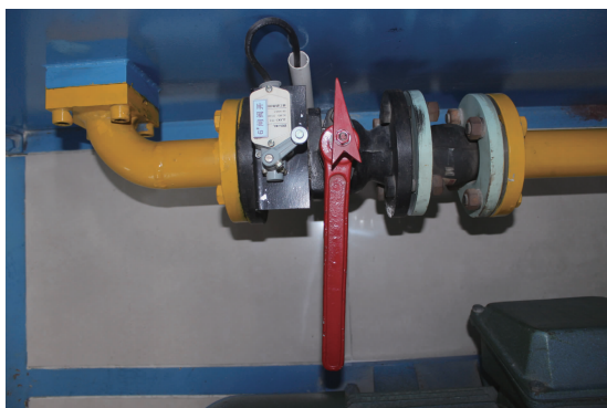
图3 截止阀关闭位置时安全装置情景
