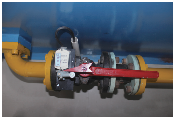
图4 截止阀打开时安全装置情景
