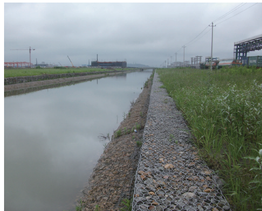
图 3 格宾网垫护坡及挡墙
