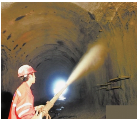
图3 喷射混凝土作业
