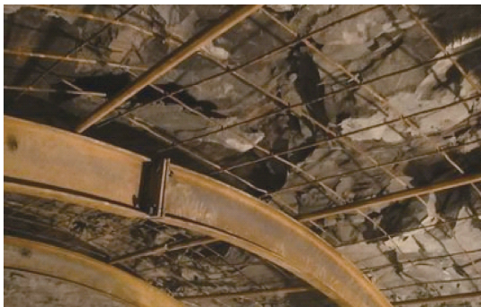
图2 顶部钢筋网及钢拱架支护
