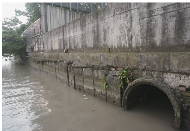
图3 祁连山路桥西侧桥台附近防汛墙现状
