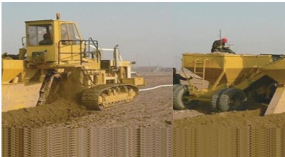
图6 改良后的机械化暗管铺设设备
