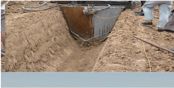
图5 新型渠道模具实物图
