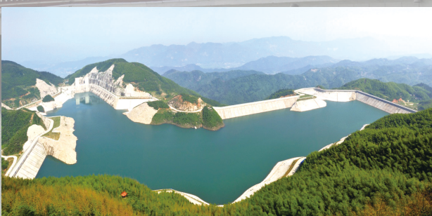
黑麋峰抽水蓄能电站
