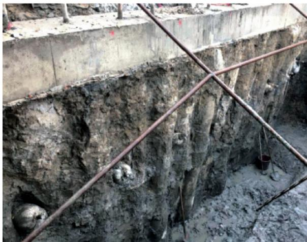
图3 钢管模袋挤密桩新型复合结构现场效果(单位:mm)
